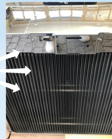
Puhdas suodatin Valmis takaisin asennettavaksi
